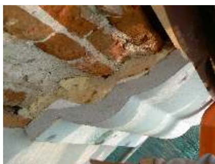
posa del profilo DEKOVER con colla poliuretanica
