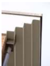
posa del profilo DEKOVER con colla poliuretanica
