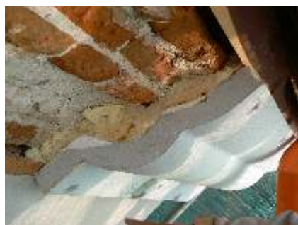
posa del profilo DEKOVER con colla poliuretanica
