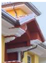
posa del profilo DEKOVER con colla poliuretanica
