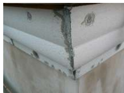
stuccatura e fissaggio del cornicione
