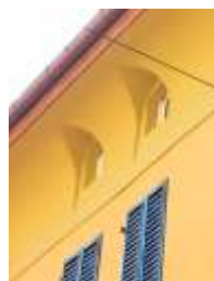
cornice sottogronda ammalorata da rivestire
