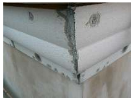
stuccatura e fissaggio del cornicione
