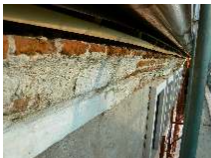
cornice sottogronda ammalorata da rivestire
