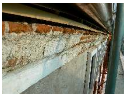
cornice sottogronda ammalorata da rivestire
