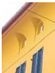
cornice sottogronda ammalorata da rivestire
