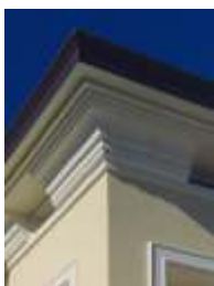
cornice sottogronda ammalorata da rivestire
