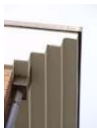
posa del profilo DEKOVER con colla poliuretanica
